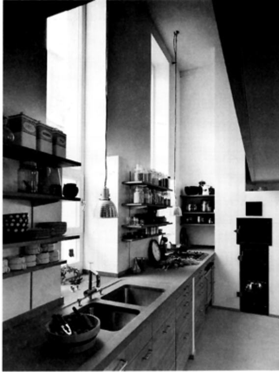
Neue Küche in der ehemaligen Rauchküche. Sichtbar sind die neue Galerie und die beiden Fensterschlitze. Boden und Schüttstein aus Sandstein.
