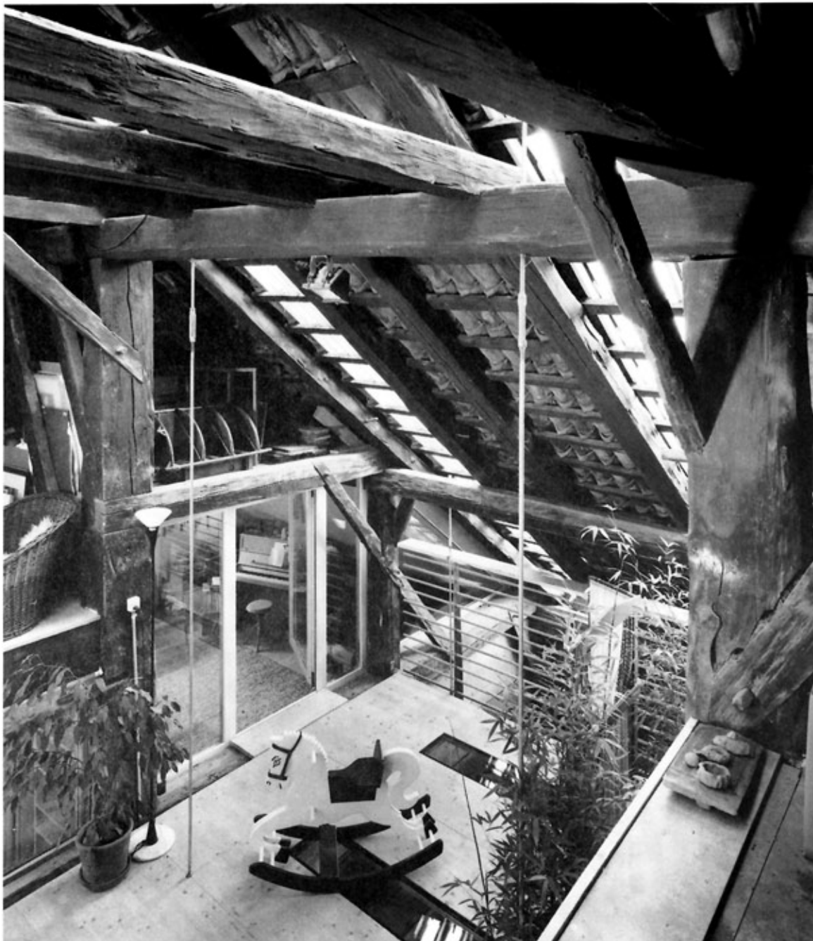
Der neue hängende Boden unter dem Dach
