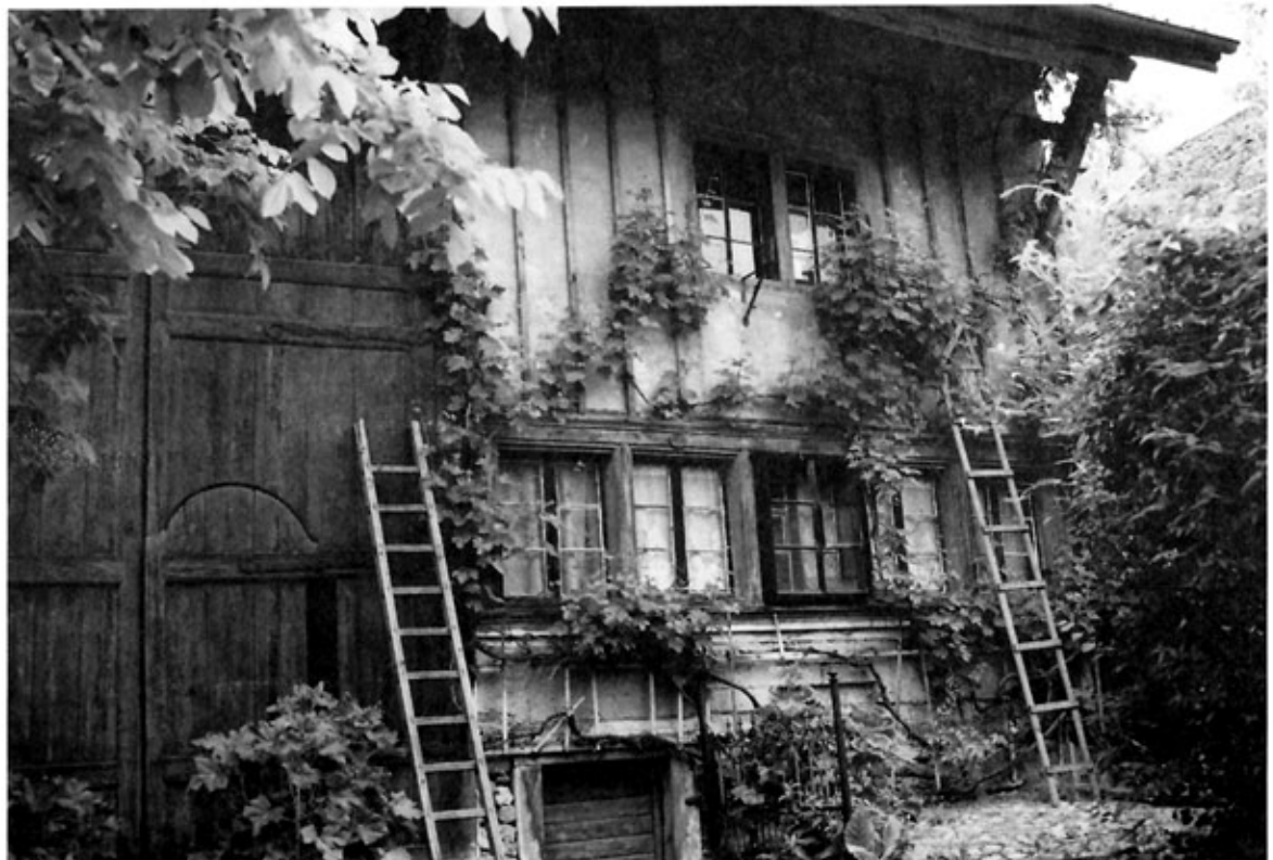
Südfassade vor der Renovation
