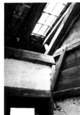
Bohlenwand von 1563 (rechts)
