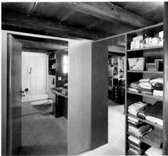
Neue Schrankfront in der nördlichen Kammer im 1. Obergeschoss. Sie ist frei hineingestellt und trennt den Bad/WC-Bereich vom Arbeitszimmer.
