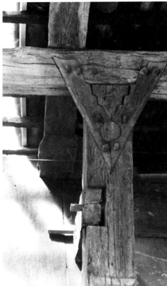
Dachstuhl (Konstruktions- details): Kopfholzpaar, Strebenanblattung mit Holznagel
